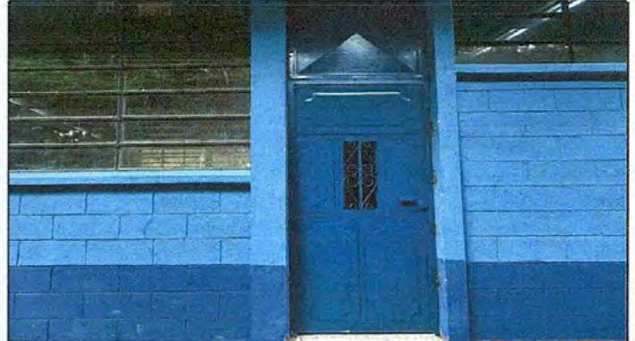
Foto 2: Sustitución de puertas de metal.
