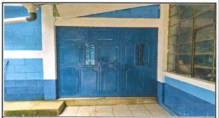
Foto 6: Sustitución de portón de metal.
