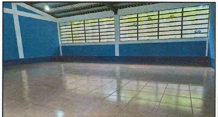
Foto 4: Sustición de piso cerámico.
