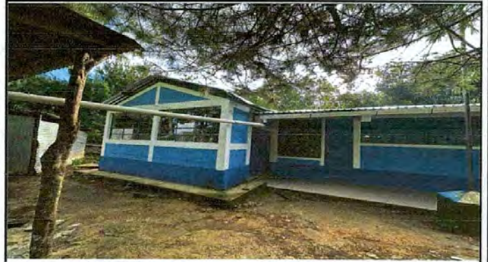
Foto 8: Sustición de canal PVC.
