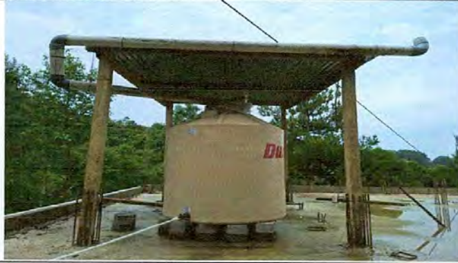
Foto7: Sustitución de depósito de agua 1750 lts.
