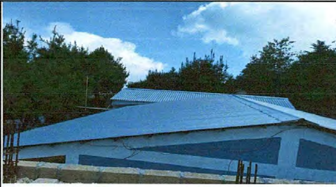
Foto1: Sustitución de láminas troqueladas calibre 24.
