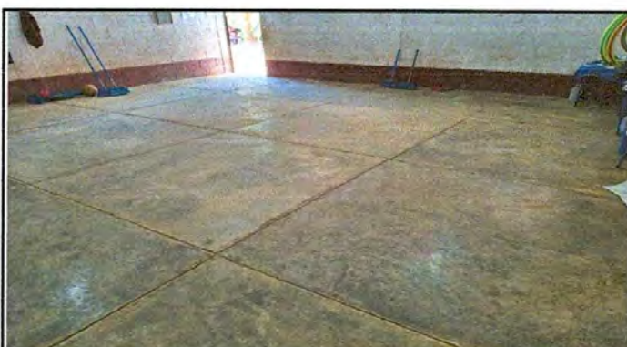
Foto 4: Sustitución de piso
