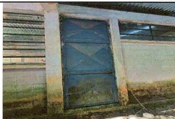
Foto 2: Sustitución de puertas de metal.
