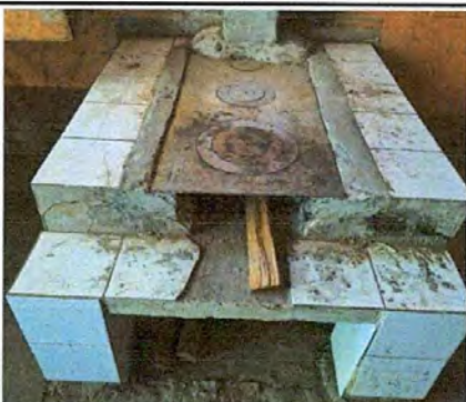
Foto 5: Sustitución de plancha de cocina.
