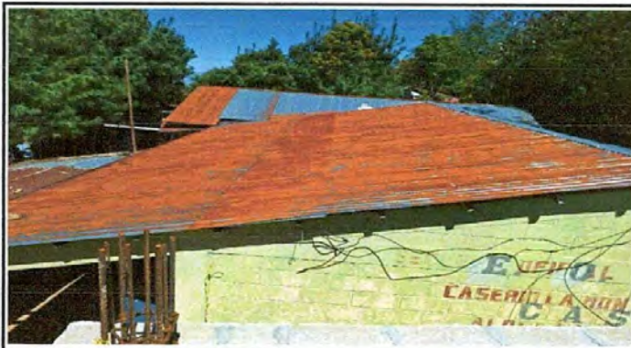
Foto 1: sustitución de láminas
