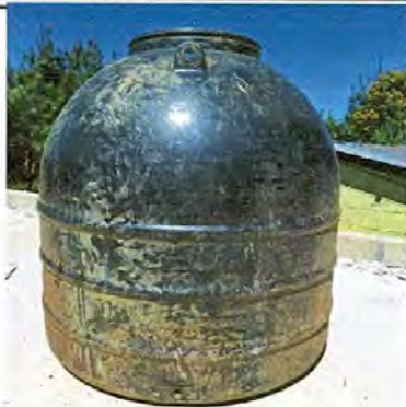
Foto 7: Sustitución de depósito de agua.
