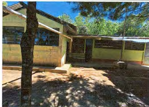
Foto 8: Sustitución de canal PVC.
