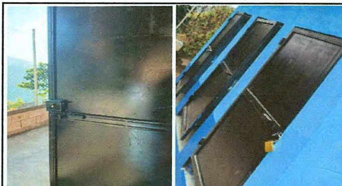
Foto 4: Mantenimiento a estructura (Lijado, cepillado y aplicación de pintura) puertas del edificio escolar y de servicios sanitarios.
