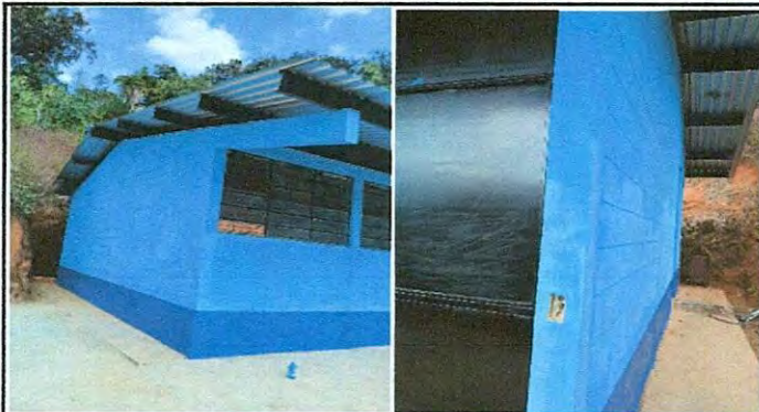
Foto1: Sustitucion de lámina por lamina troquelada calibre 26 y capotes de lámina para lamina troquelada.
