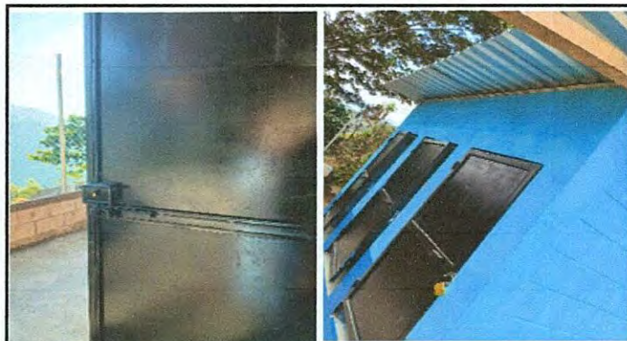
Foto 10: Sustitucion de chapas y candados.
