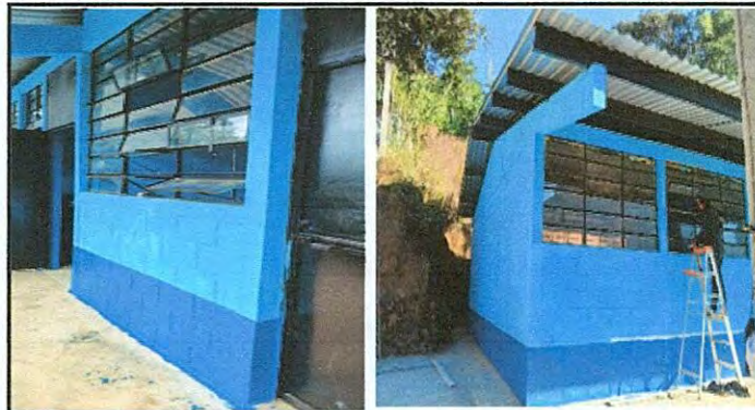
Foto 8: Sustitucion de vidrios
