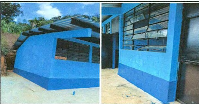
Foto 5: Mantenimiento a estructura de metal de ventanas
