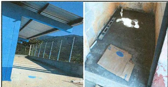
Foto 11: Sustitucion de piso de torta de concreto.
