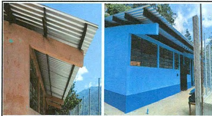
Foto 2: Mantenimiento a estructura de soporte de metal
