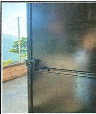
Foto 10: Sustitucion de chapas.
