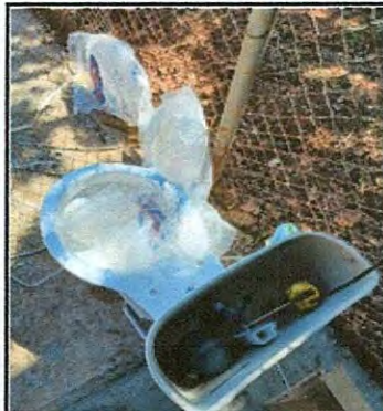
Foto 7: Sustitucion de inodoro y de accesorios contra llave, tubo de abasto y tanque.
