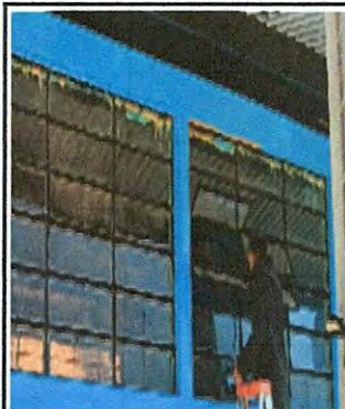
Foto 8: Sustitucion de vidrios
