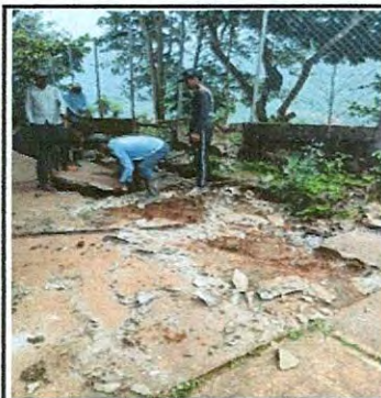
Foto 11: Sustitucion de piso de torta de concreto.
