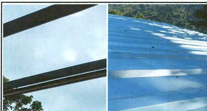
Foto 3: Sustitucion de techo por lamina troquelada calibre 26. y de estructura de soporte de metal (Servicios sanitarios)
