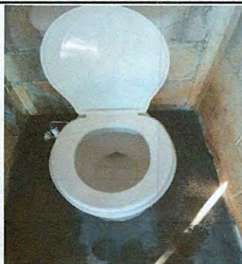
Foto 7: Sustitucion de inodoro y de accesorios contra llave, tubo de abasto y tanque.
