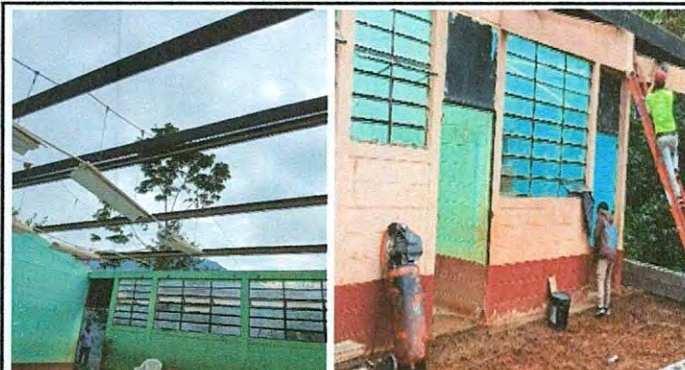
Foto 2: Mantenimiento a estructura de soporte de metal
