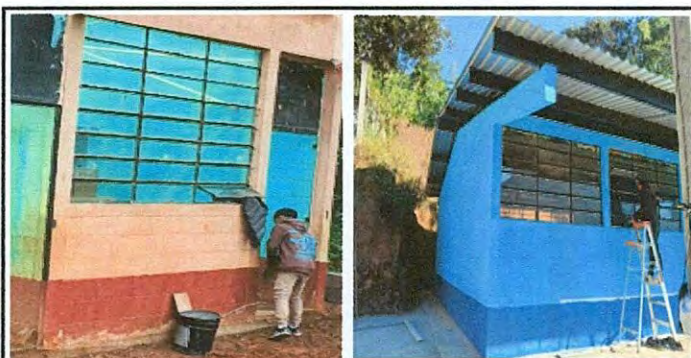
Foto 5: Mantenimiento a estructura de metal de ventanas
