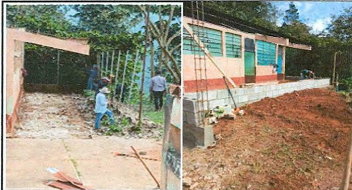
Foto 14: Sustitución de muro perimetral de block con tubo hg y malla galvanizada, soleras intermedias y columnas.
