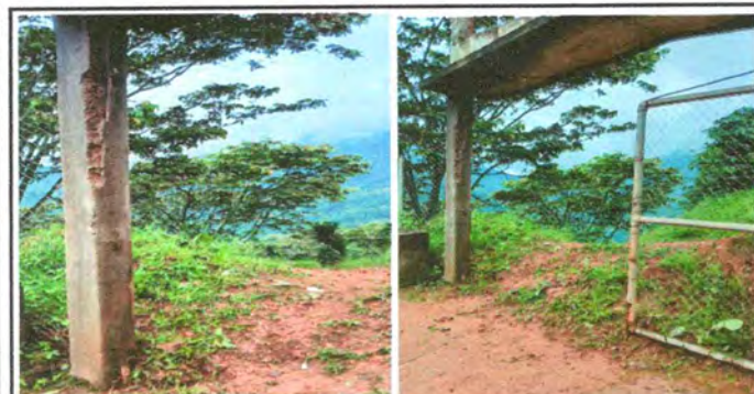
Foto 9: Sustitucion de portón de metal.
