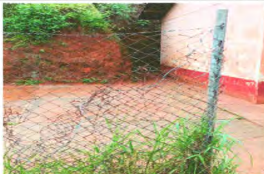
Foto 14: Sustitución de muro perimetral de block con tubo hg y malla galvanizada, soleras intermedias y columnas.
