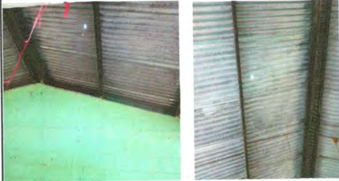
Foto1: Sustitucion de lámina por lamina troquelada calibre 26 y capotes de lámina para lamina troquelada.
