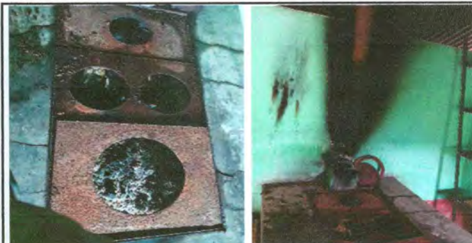
Foto 12: Sustitucion de plancha de metal de 3 hornillas y chimenea de metal.
