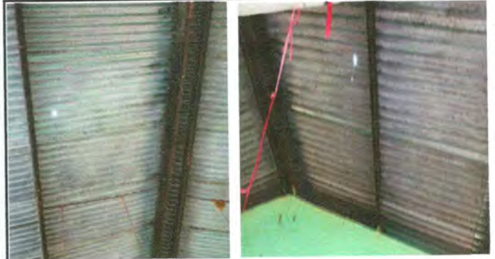
Foto 2: Mantenimiento a estructura de soporte de metal
