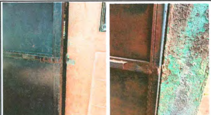
Foto 10: Sustitucion de chapas.
