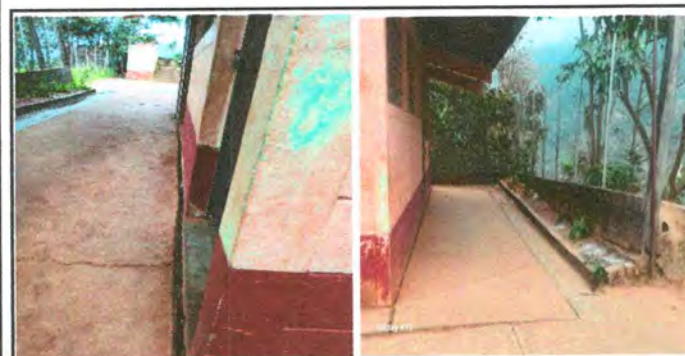
Foto 11: Sustitucion de piso de torta de concreto.
