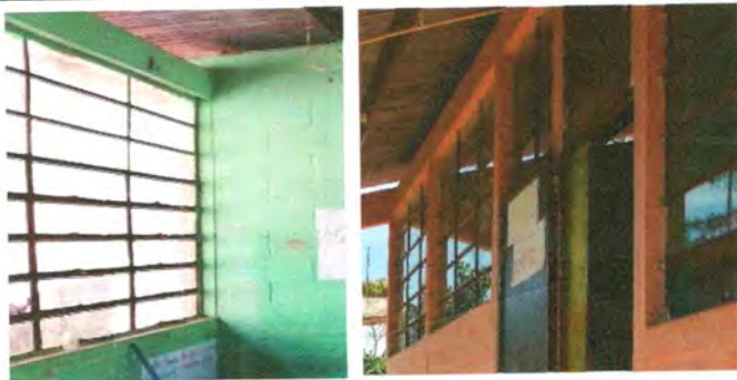
Foto 5: Mantenimiento a estructura de metal de ventanas
