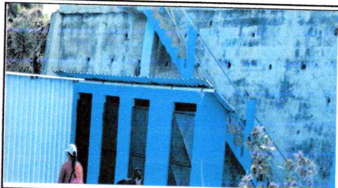
Foto 2: Sustrucción de estructura de madera, por estructura metal
