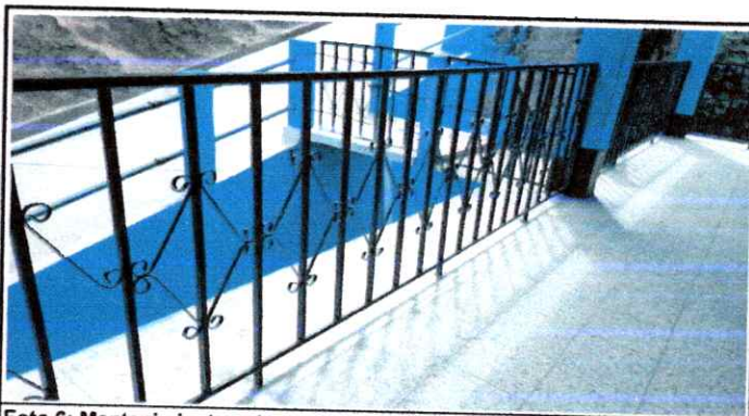
Foto 6: Mantenimiento a barandas
