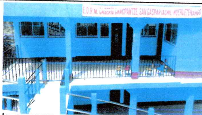
Foto 8: Sustitución de vidrios
