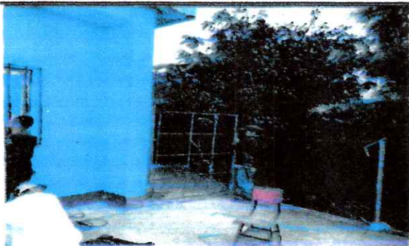
Foto 7: Instalación de portón
