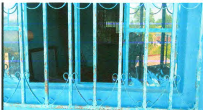
Foto7: Sustitución de de estructura metal de ventanas
