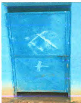
Foto 5: Sustrucción de puerta de metal
