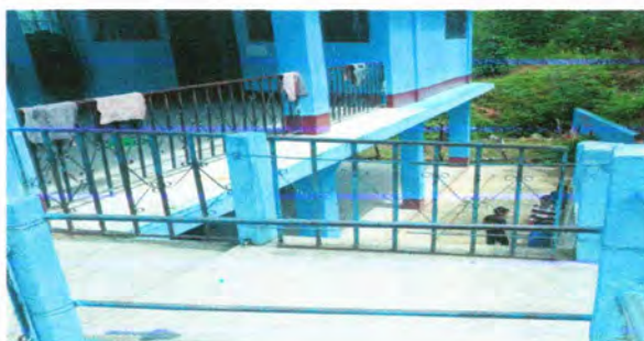
Foto 6: Sustrucción de barandas
