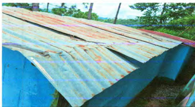
Foto1: Sustrucción de láminas
