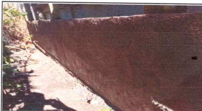
Foto 4: Reparación de muro de contención
