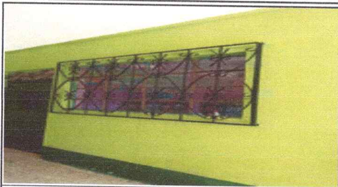
Foto 2: Reparación de balcones
