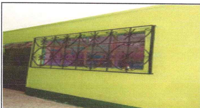
Foto 4: Reparación de balcones
