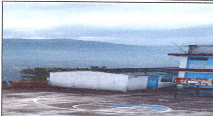
Foto 1: Mantenimiento de costanera
