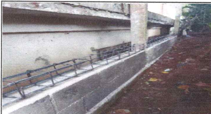
Foto 3: Reparación de muro de contención
