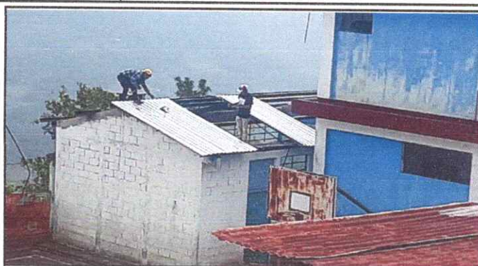
Foto 2: Sustitución de lamina
