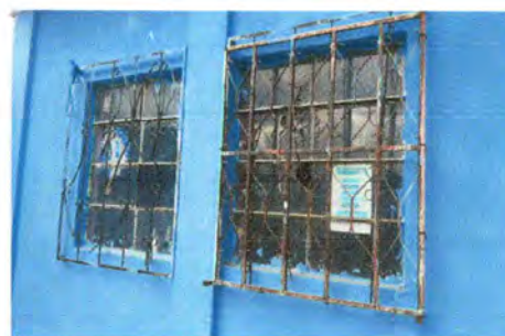
Foto 4: Fabricación e instalación de ventanas de metal por PVC
