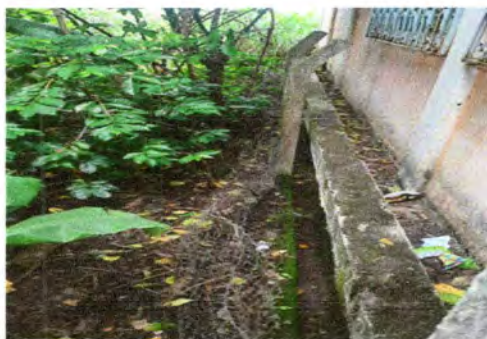
Foto 5: Reparación de muro perimetral con piedra y cemento
