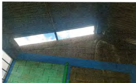
Foto 2: Sustrucción de capote de lámina para lámina troquelada
