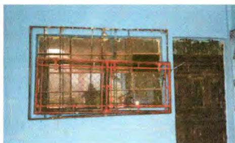
Foto 3: Fabricación e instalación de balcones de hierro en ventanas
