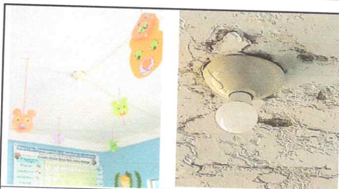
Foto 6: Reparacion de cableado electrico y accesorios
