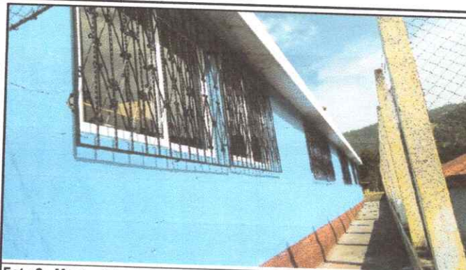
Foto 2: Mantenimiento a balcones de metal ( soldaduras, lijada y pintada )
