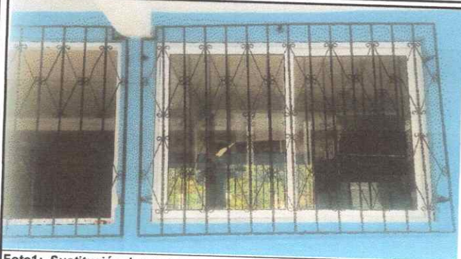
Foto1: Sustrucción de ventanas
