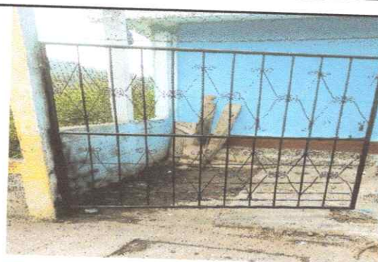
Foto 4: Mantenimiento a porton de metal
