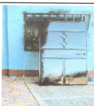
Foto 5: Mantenimiento para puertas de las aulas y bodegas ( lijado y aplicación de pintura)
