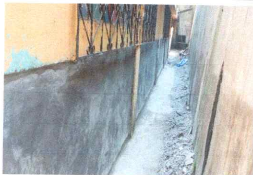
Foto1: Terminación de repello
