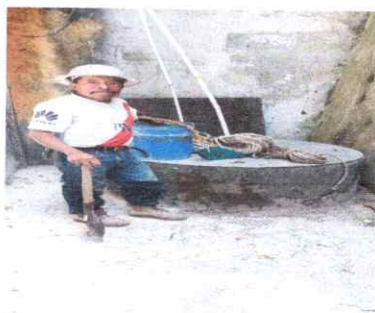
Foto 5: Terminación de cambio de bomba de poso
