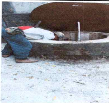
Foto 5: Proceso de cambio de bomba de poso
