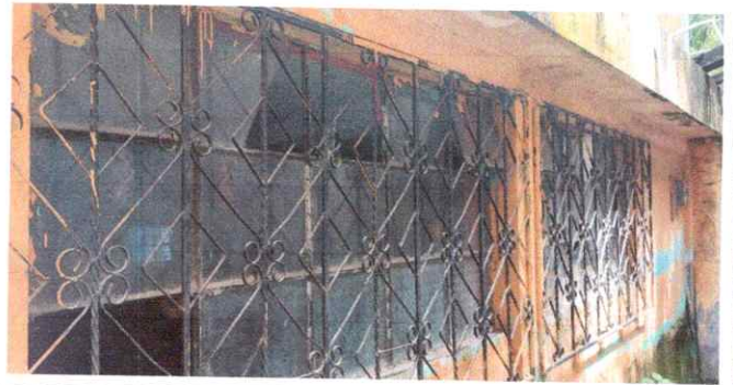
Foto 2: Proceso de ventanas
