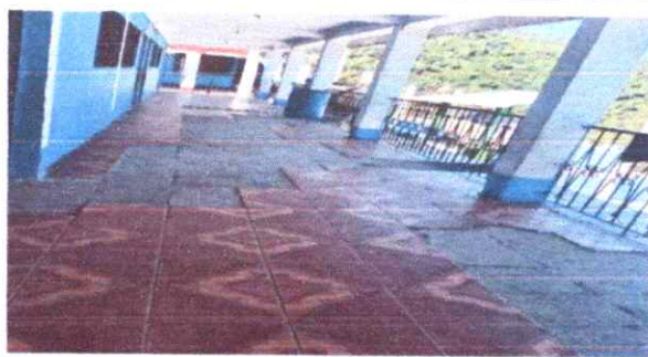
Foto 4: Reparación de Piso
