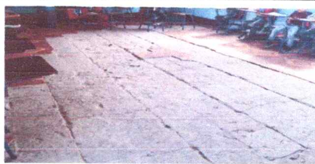
Foto 6: Reparación de Piso
