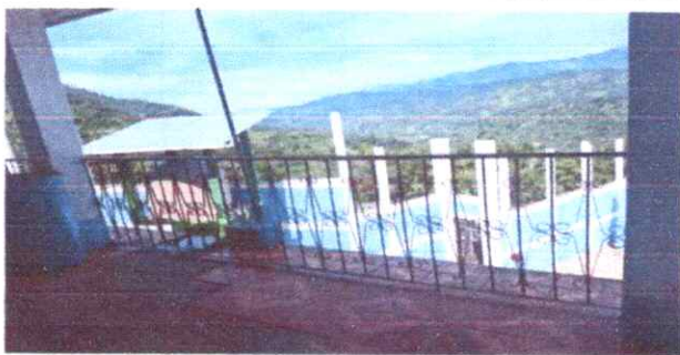
Foto 5: Mantenimiento a Baranda
