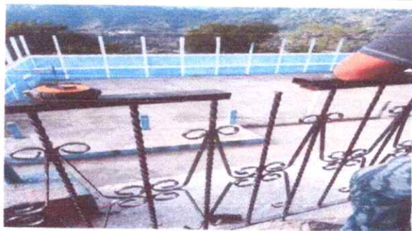
Foto 5: Mantenimieto de Baranda
