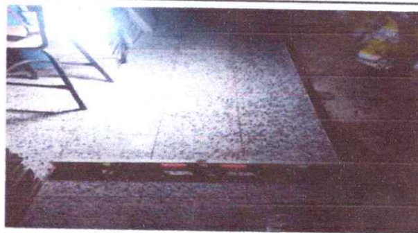
Foto 4: Repación de Piso
