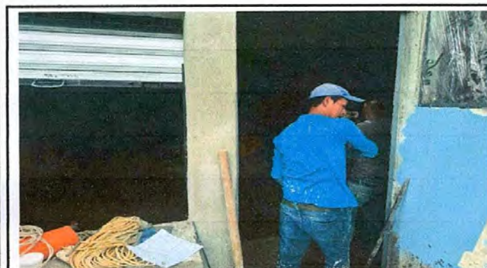
Foto 3: Sustitución de ventanas.
