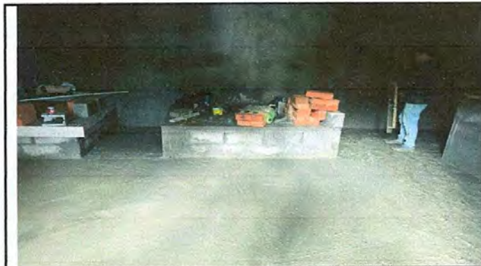
Foto 4: Sustitución de Piso
