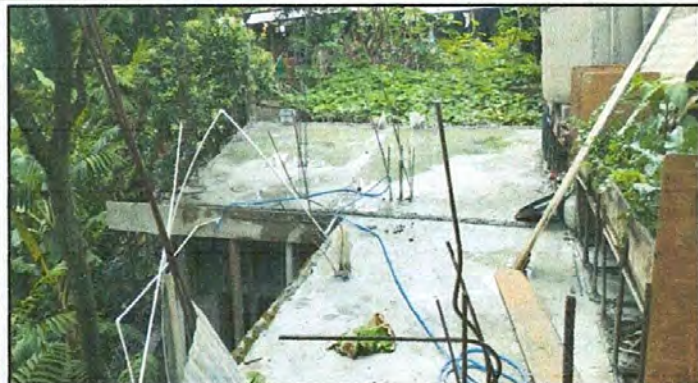
Foto 1: Ipermeabilización de loza.
