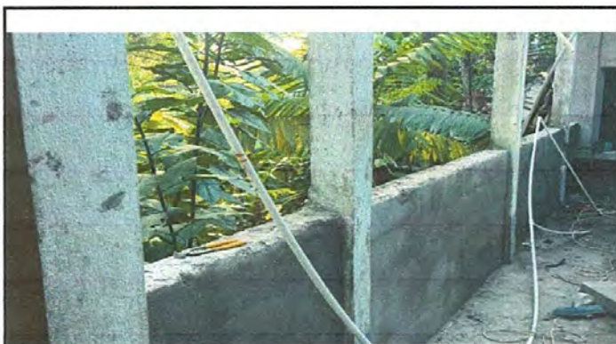
Foto 12: Reparación de muro de contención.
