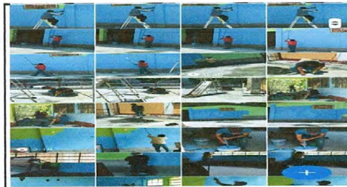
Foto 6: Pintura en muro interiores y exteriores.
