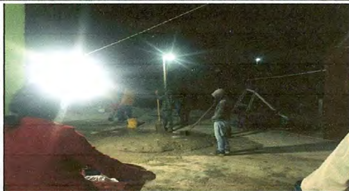
Foto 1: Impermeabilización de loza.
