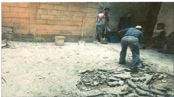
Foto 4: Sustitución de Piso
