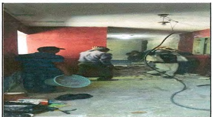
Foto 3: Sustitución de ventanas.
