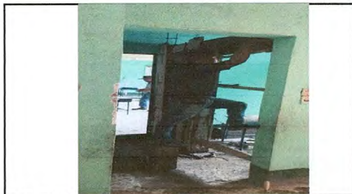
Foto 12: Reparación de muro de contención.
