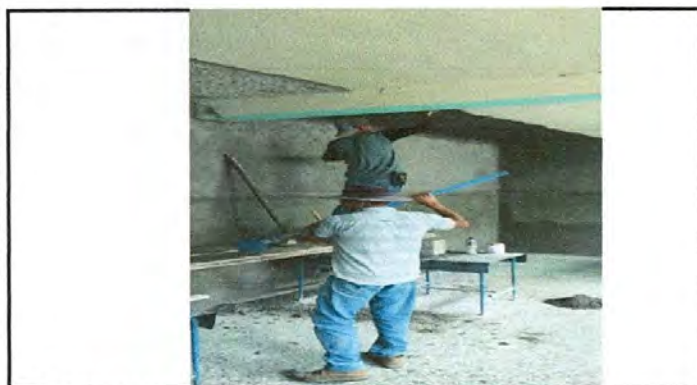
Foto 11: Reparación de repello y cernido de paredes
