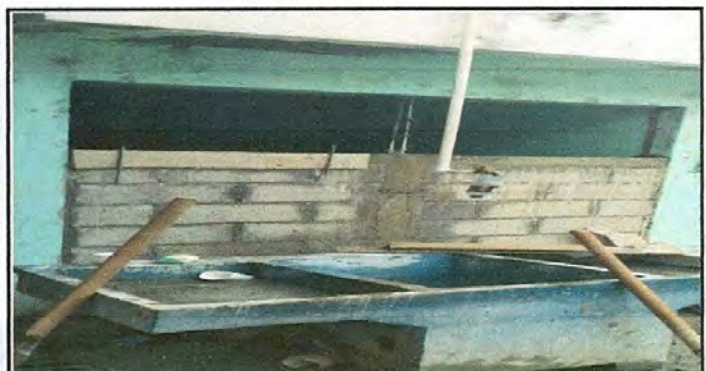
Foto 5: Canales y bajadas de agua pluvial
