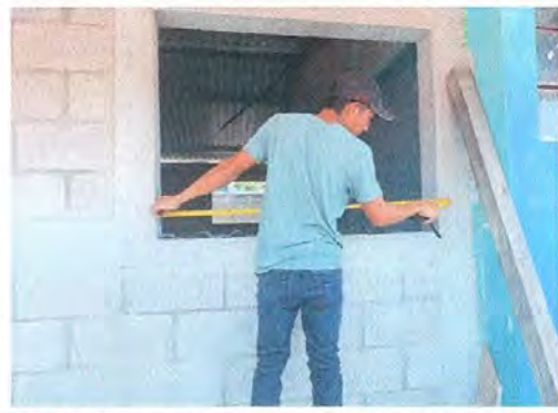
Foto 8: Fabricación y elaboracion de Ventana para aula en proceso
