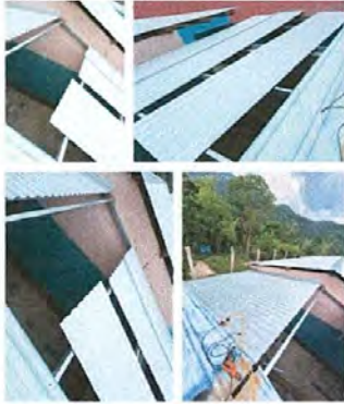
Foto1: Sustitucion de techo de aula en proceso
