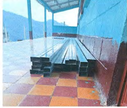
Foto 2: Sustitucion de soporrtte de madera en proceso
