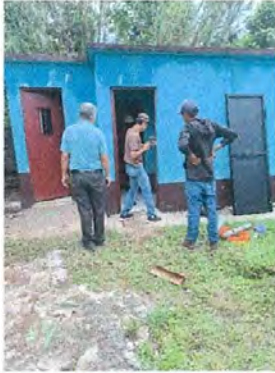
Foto7: Sustitución de puerta en proceso
