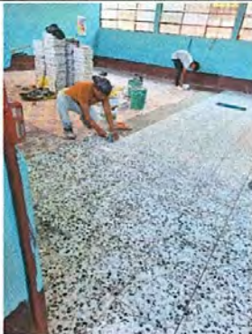
Foto 9: Sustitución de Piso en proceso
