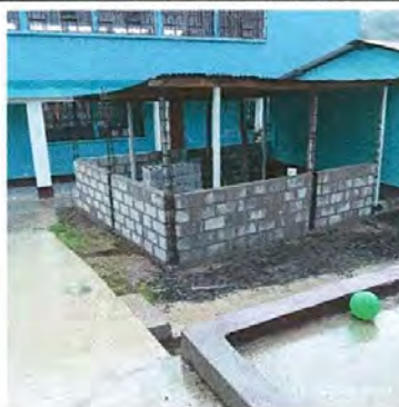
Foto 14: Sustitucion de lamina proceso
