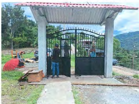
Foto 15: Sustitución de portón principal, proceso
