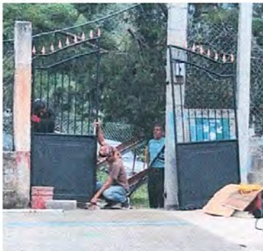
Foto 5: Sustitución de Portón en proceso
