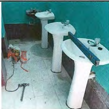
Foto 11: Sustitución de lavamanos en proceso
