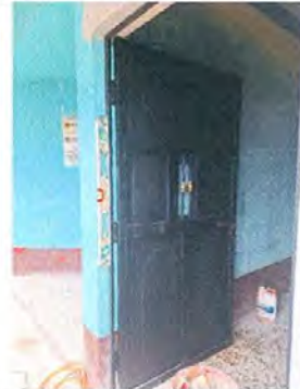
Foto 6: Sustitución de puerta para aula en proceso
