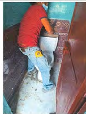
Foto 10: Sustitución de sanitarios en proceso
