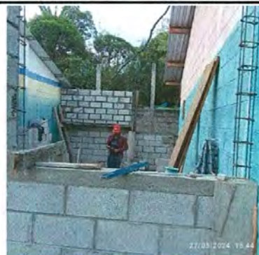
Foto 12: Sustitucion de pared de lámina a 5 hiladas de block en proceso
