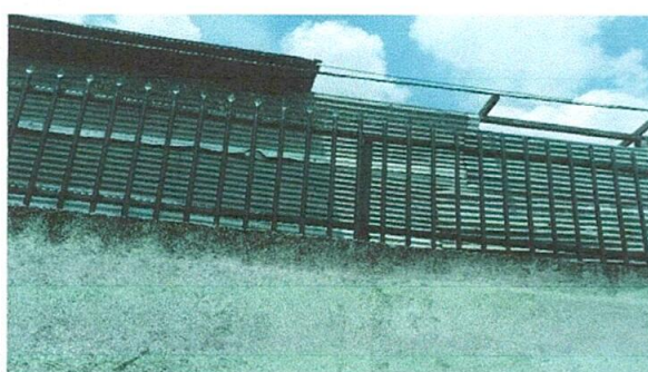
Foto 4: Barandas puestas y listo trabajo concluido
