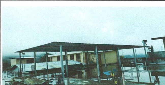
Foto 6: Nuevo techado de la pila
