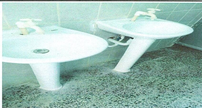
Foto 1: Instalacion de lavamanos nuevos
