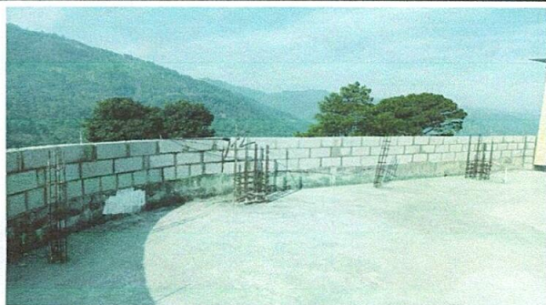
Foto 5: Proyecto muro perimetral puesto
