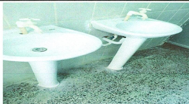
Foto 2: Instalacion de lavamanos nuevos
