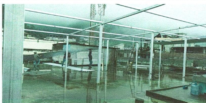
Foto 6: Techado en construcción
