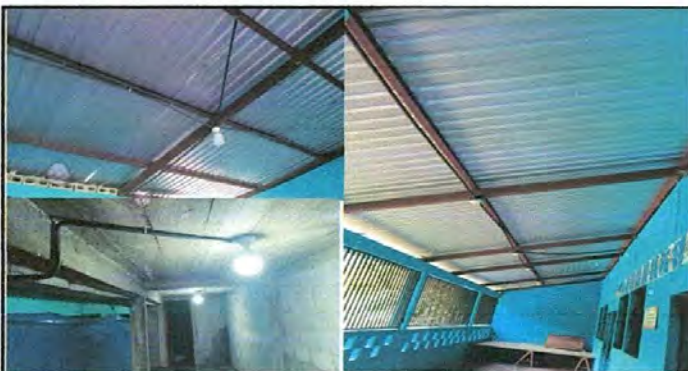
Foto No. 5 Se observan que ya están colocados los nuevos cableados eléctricos en las aulas, corredor y bodega del centro educativo.
