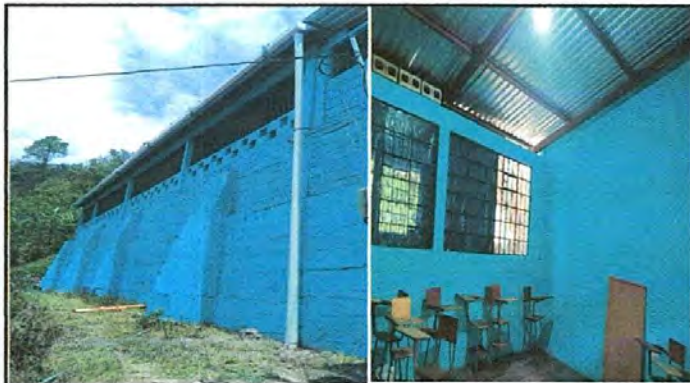
Foto No. 8 En estas imágenes se observan que ya están terminadas la pintada del muro exterior y la pintada en las aulas del centro educativo.
