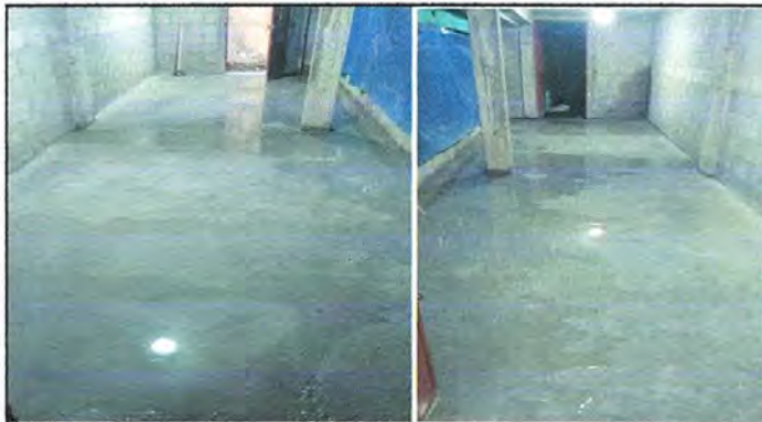
Foto No. 7 Se observan que ya está colocada el piso de torta de concreto en la bodega del centro educativo.
