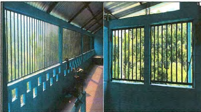
Foto No. 3 se observan que ya están colocadas todas las barandas en el corredor del centro educativo para evitar accidentes en los estudiantes
