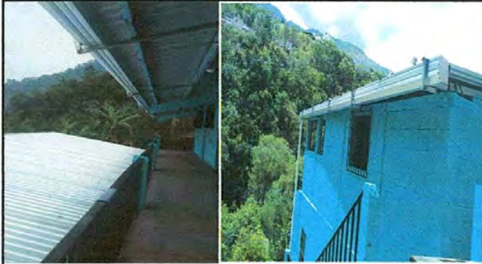
Foto No. 1 En estas imágenes se observan que ya está terminada este renglón de trabajo de colocación de canales en el centro educativo.
