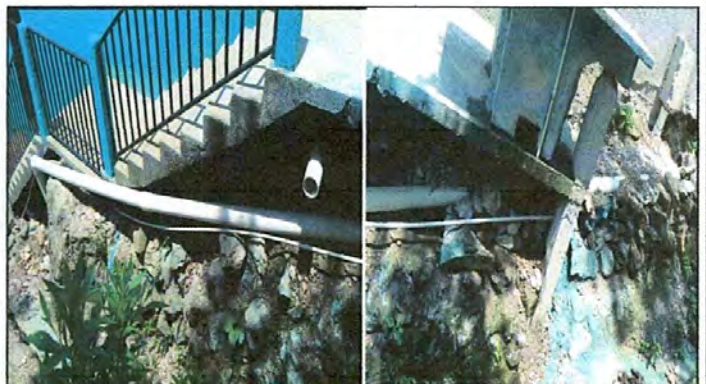
Foto No. 4 En estas imágenes se observan que ya están colocadas e instaladas las nuevas tuberías de alta presión que durará muchos años.
