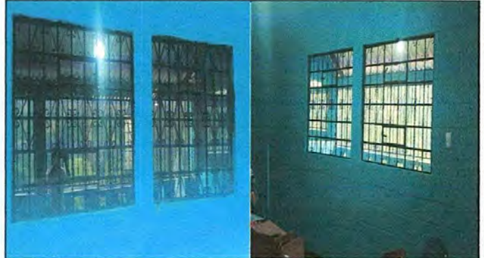
Foto No. 2 Se observa que ya están colocadas todos los vidrios de las ventanas de las aulas en el centro educativo.
