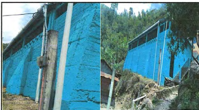
Foto No. 10 En estas fotografías se observan que ya están colocadas las bajadas de agua pluvial en los canales del centro educativo.
