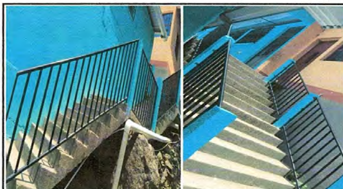
Foto No. 9 En estas fotografías se observa que ya están colocadas todas las barrandas de graderío exterior del centro educativo
