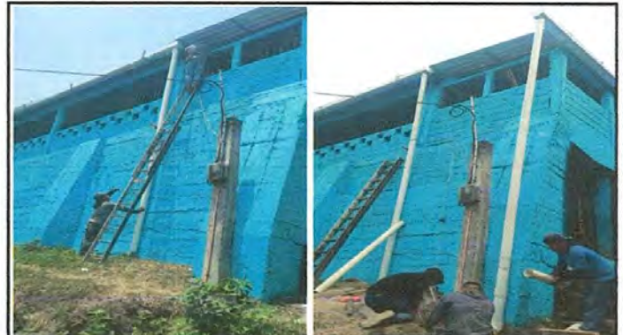
Foto No. 10 Aquí se observa que se esta colocando las bajadas de agua pluvial en los canales del centro educativo.
