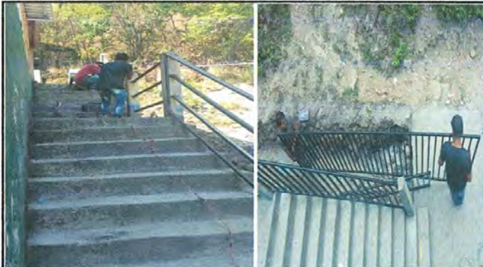
Foto No. 9 Se observa que se esta colocando las barrandas de graderio exterior del centro educativo.
