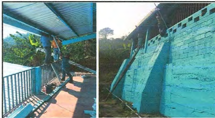
Foto No. 1 En estas imágenes se observa que se esta trabajando este renglon de trabajo de colocación de canales en el centro educativo.
