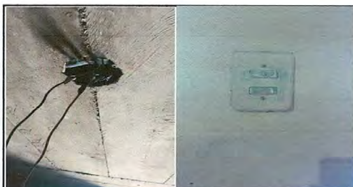
Foto No. 6 Los apagadores o swich estan en mal estado así mismo las plafoneras ya estan quebradas.
