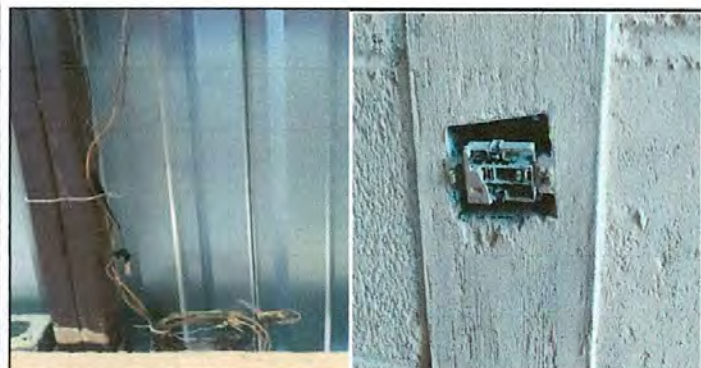
Foto No. 5 El cableado electrico en las aulas estan en mal estado tambien los tomacorrientes estan quebradas.
