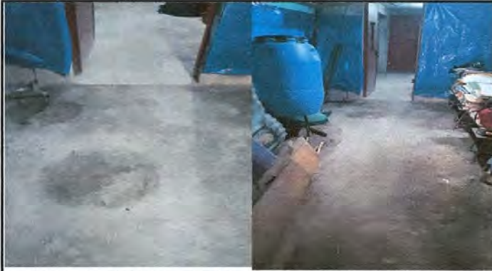
Foto No. 7 El piso de la bodega donde se resguarda la alimentación escolar esta en mal estado, le falta colocar el piso de torta de concreto.
