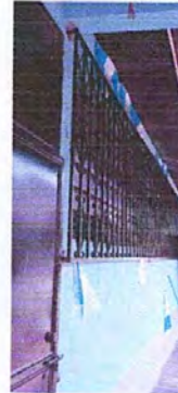
Foto 8. Fabricación e instalación de balcones de hierro en ventana.
