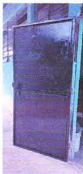
Foto 1. Mantenimiento de puerta, lijar y pintar
