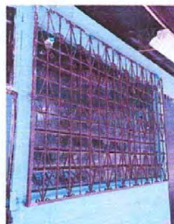
Foto 2. Sustitución de vidrios, por nuevas
