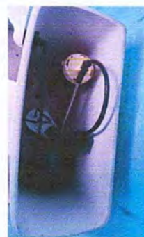
Foto 4. Sustitución de accesorios inodoros ( completos )
