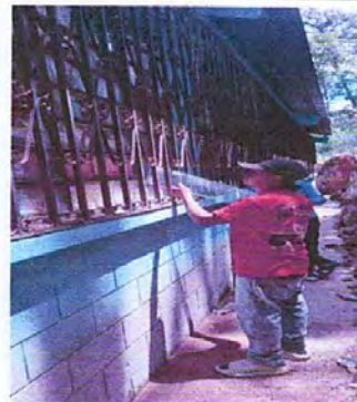
Foto 2. Sustitución de vidrios, por nuevas
