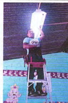
Foto 6. Sustitución de sistema eléctrico, por lámparas LED
