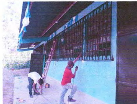
Foto 8. Fabricación e instalación de balcones de hierro en ventana.
