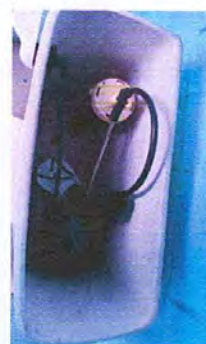
Foto 4. Sustitución de accesorios inodoros (completos)
