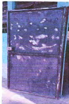
Foto 1. Mantenimiento de puerta, lijado y pintar
