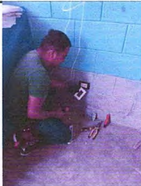
Foto 7. Interruptores, toma corrientes en mal estados
