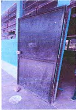
Foto 1. Mantenimiento de puerta, lijado y pintar
