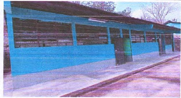
Foto 8. Fabricación e instalación de balcones de hierro en ventana.
