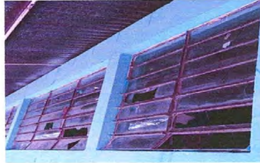
Foto 2. Sustitución de vidrios, por nuevas
