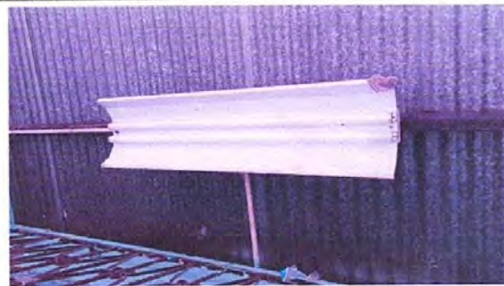
Foto 6. Sustitución de sistema eléctrico, por lamparas LED
