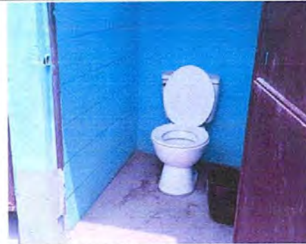
Foto 4. Sustitución de accesorios inodoros ( completos )
