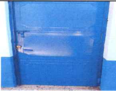
FOTO 3 Puertas de las aulas de la escuela
