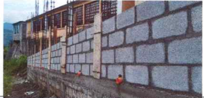
FOTO 2 de esta manera se refuerzan las columnas y se rellena el block para resistencia del muro y seguridad de los niños
