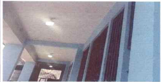
FOTO 4 SE PROCEDE A LA COLOCACION DE LAMPARAS LED
