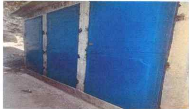
FOTO 2 Puertas nuevas de los sanitarios de la escuela
