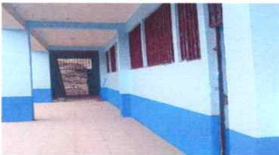
FOTO 5 Pintura en muros interiores y exteriores de la escuela.
