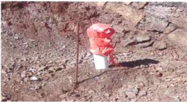
FOTO 3 nuevo renglon que se implemento de drenaje Y SE COLOCA LA TUBERIA NECESARIA Y CORRESPONDIENTE
