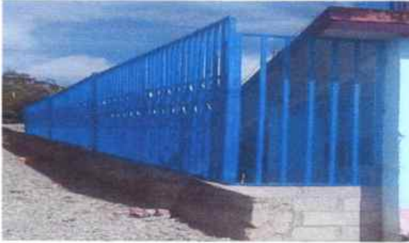
FOTO 1 se procede a la sustitucion de laminas y colocacion de baranda de metal para seguridad de los niños
