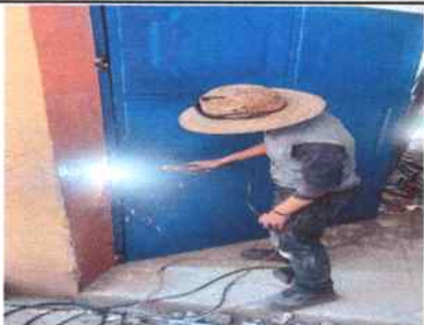
FOTO 1 Se procede a sustitucion y colocacion de porton de las entradas principales de la escuela
