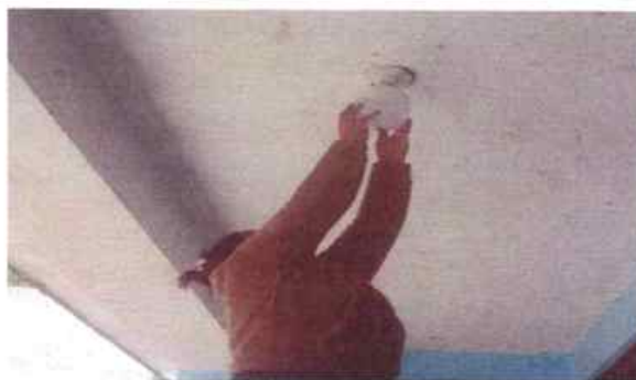
FOTO 4 SE PROCEDE A LA COLOCACION DE LAMPARAS LED
