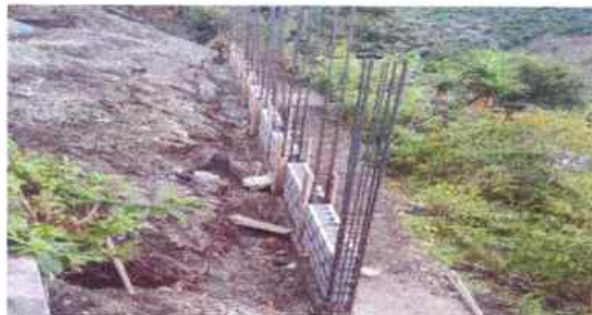
FOTO 2 de esta manera se refuerzan las columnas y se rellena el block para resistencia del muro y seguridad de los niños
