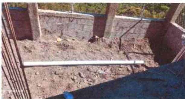
FOTO 3 nuevo renglón que se implemento de drenaje Y SE COLOCA LA TUBERIA NECESARIA Y CORRESPONDIENTE
