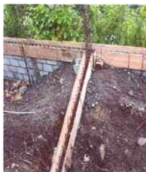
FOTO 6 Avance de los trabajos de reparacion de muro de contencion reforzado con costillas para seguridad y para una proxima construccion
