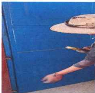
FOTO 3 Se procede a la sustitucion y colocacion de puertas de las aulas de la escuela
