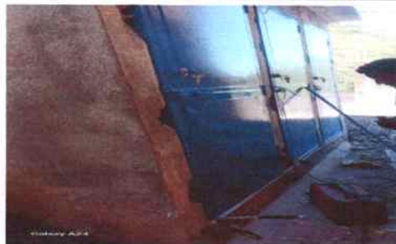
FOTO 2 Se procede a la sustitucion y colocacion de puertas de los sanitarios de la escuela
