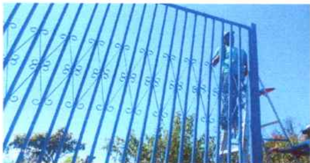
FOTO 1 se procede a la sustitucion de laminas y colocacion de baranda de metal para seguridad de los niños
