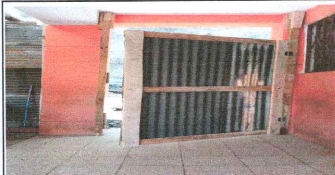
FOTO 2 sustitucion de porton que se encuentra al fondo de la escuela
