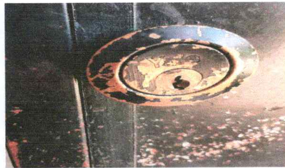
FOTO 4 cambio de chapa para puerta de metal
