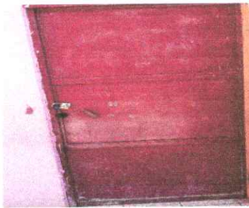
FOTO 3 sustitucion de puertas por estar deterioradas y en mal estado
