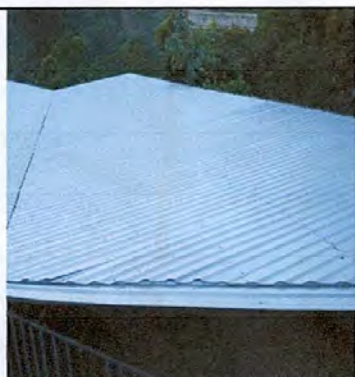
Foto 3: Láminas instaladas enfrente de las aulas del Módulo 1.
