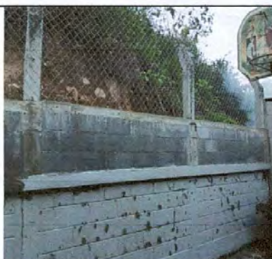
Foto 6: Muro perimetral reparada y ampliada atrás de las aulas del Módulo 1. con su respectivo malla galvanizada.
