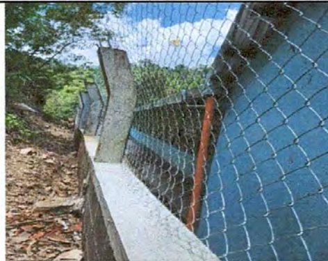
Foto 8: Muro perimetral reparada y ampliada con su respectivo malla galvanizada atrás de las aulas del Módulo 1.
