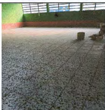
Foto 5: Piso de granito instalada en las aulas.
