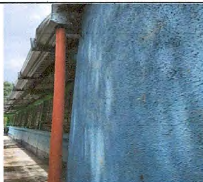
Foto 12: Canales y tubos para bajadas de agua instaladas en los techos de la cocina y atrás de las aulas del Módulo 1.
