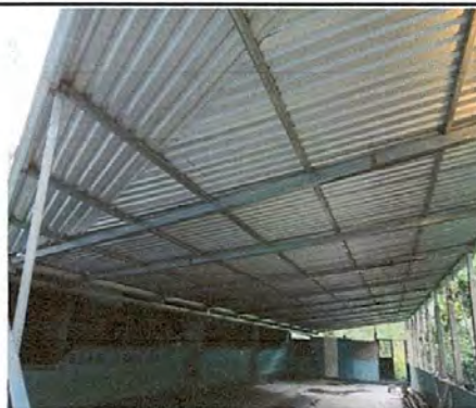
Foto 2: Estructura de soporte de metal y láminas instaladas enfrente de las aulas del Módulo 1.
