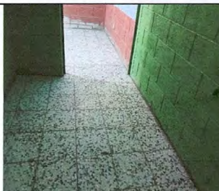
Foto 4: Pisos de granito en las bodegas.
