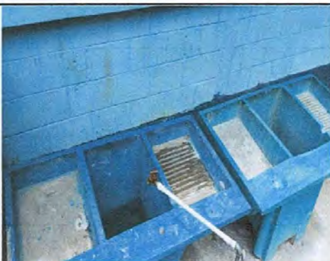
Foto 11: Chorro del agua potable instalada.
