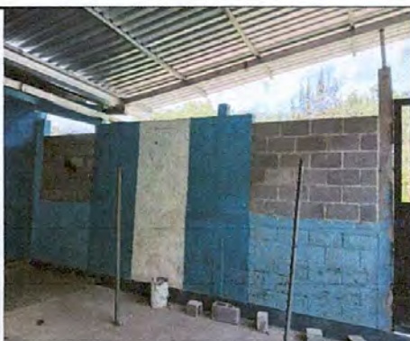
Foto 9: Muro de Block reparada y ampliada enfrente de las aulas del Módulo 1.
