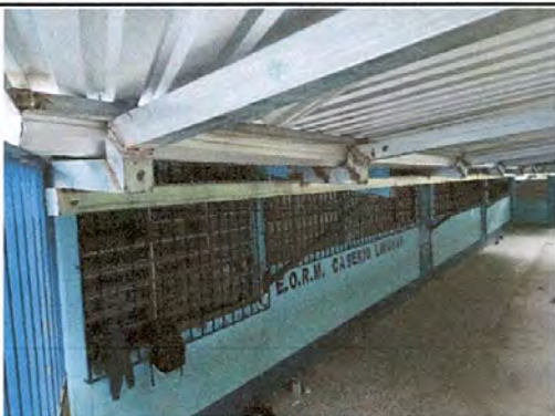
Foto 1: Estructura de soporte de metal instalada enfrente de las aulas del Módulo 1.
