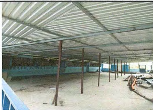
Foto 2: Instalación de láminas enfrente de las aulas.
