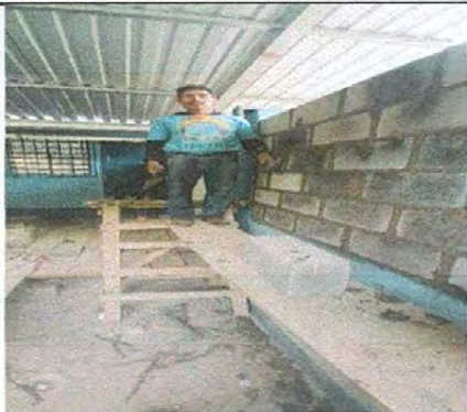
Foto 7: Colocación de block para ampliar el muro perimetral enfrente de las aulas.
