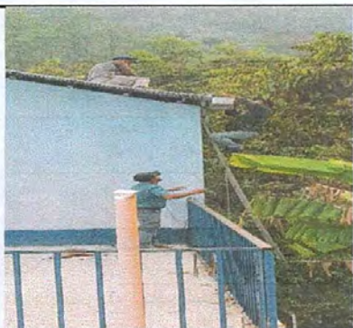
Foto 11: Colocación de canales atrás de las aulas en modulo 2.
