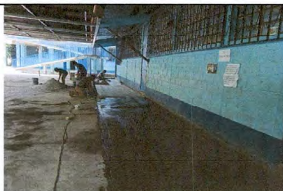
Foto 4: Colocación de piso en el corredor de las aulas.
