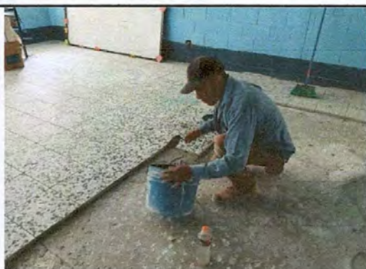
Foto 3: Colocación de piso de granito en las aulas.
