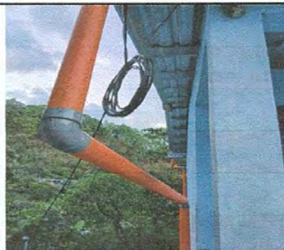
Foto 12: Colocación de canales de metal y tubos para bajadas de agua.
