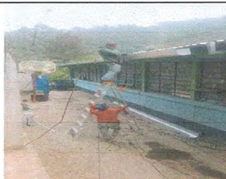
Foto 10: Colocación de canales atrás de las aulas.
