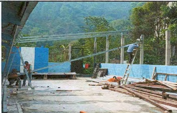
Foto 1: Instalación de estructura de soporte de metal.
