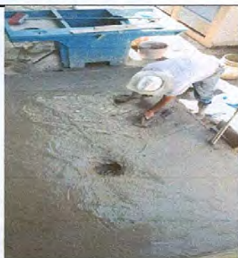
Foto 5: Fundición de piso de concreto para las pilas.
