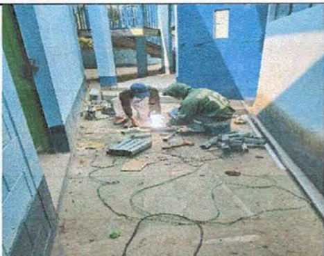
Foto 9: Realización de piezas de metal para el soporte de canales.
