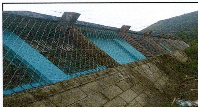
Foto 3. Sustitución de malla calvanizada
