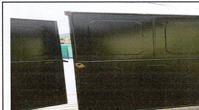
Foto 6. Sustitución de portón metálico
