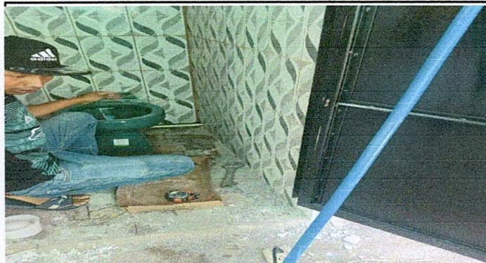
Foto 2. Sustitución de puertas de baños
