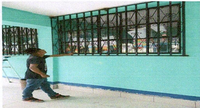
Foto 1. Instalación de balcones en dos aulas
