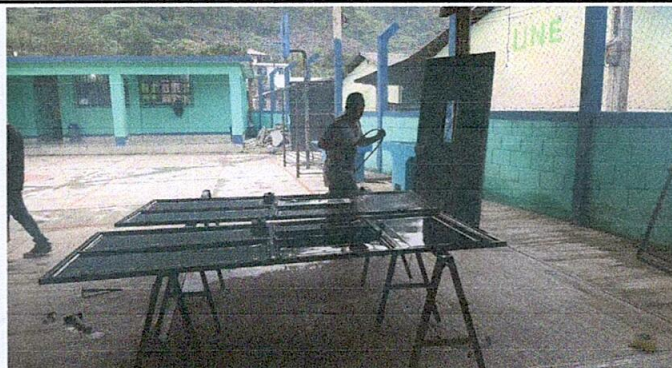
Foto 2. Sustitución de puertas para baños y puerta de aula
