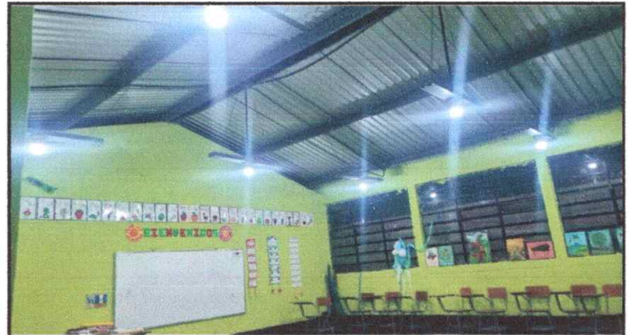
Foto 4: Reparación del sistema eléctrico.
