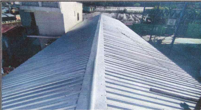
Foto1: Sustitución de lámina, por lámina troquelada aluzinc
