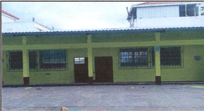
Foto 3: Mejoramiento de paredes de block en aulas
