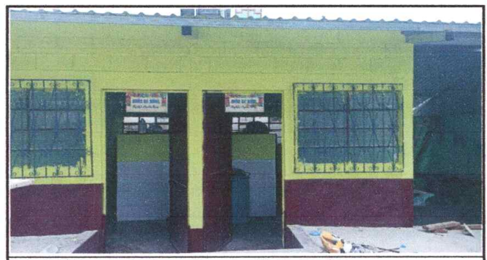
Foto 6: Mejoramiento de repello y cernido de paredes
