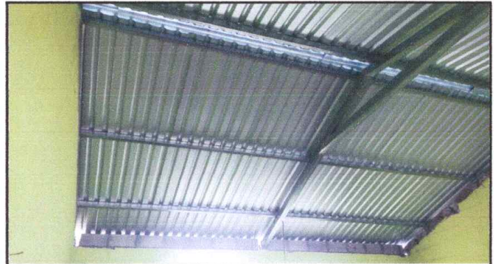
Foto 2: Sustitución de estructura de madera por metal.
