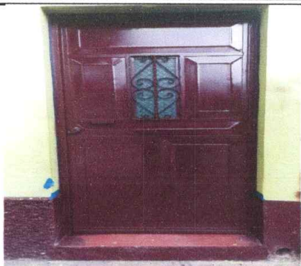
Foto1: Mejoramiento de puerta de metal
