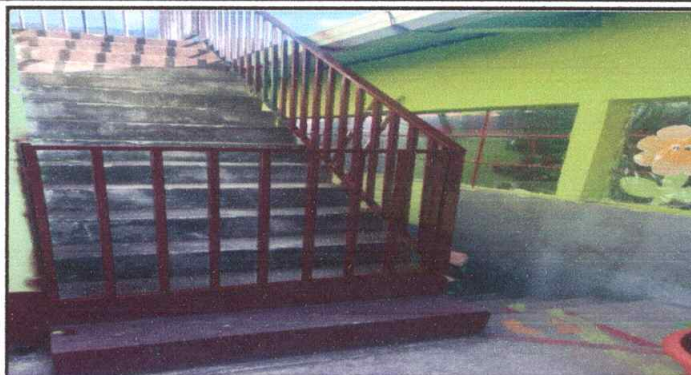
Foto 2: Mejoramiento de baranda de metal
