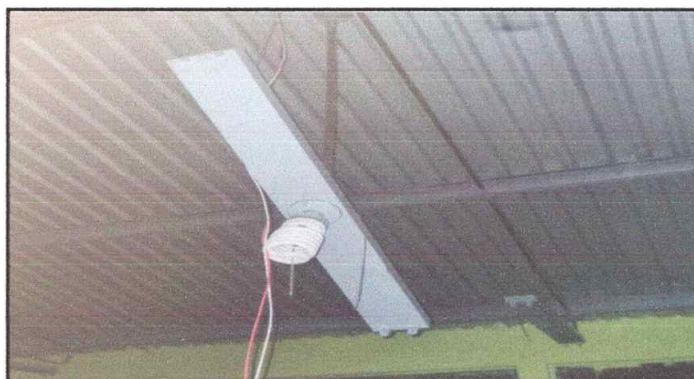
Foto 4: Reparación del sistema eléctrico.
