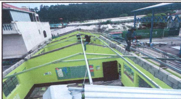
Foto 2: Sustitución de estructura de madera por metal.
