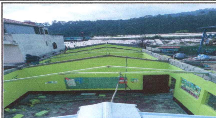
Foto1: Sustitución de lámina, por lámina troquelada aluzinc
