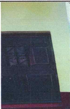
Foto1: Mantenimiento de puerta de metal
