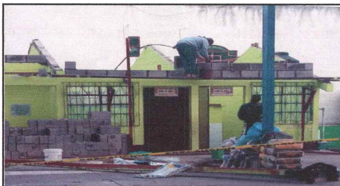
Foto 3: Mejoramiento de paredes de block en aulas
