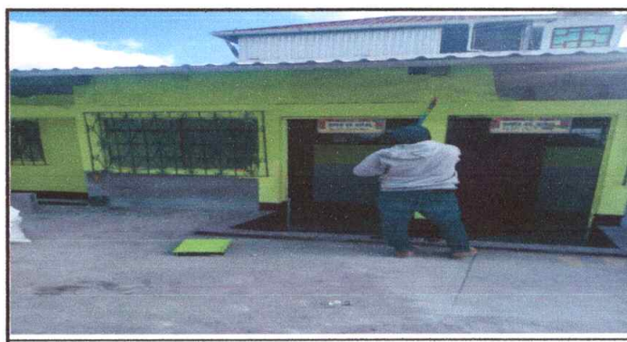
Foto 6: Repello y cernido de paredes
