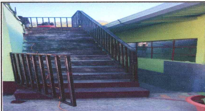
Foto 2: Mantenimiento de baranda de metal
