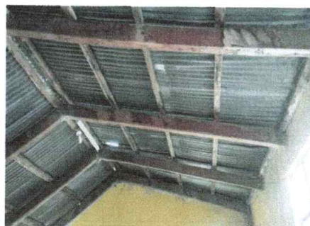
Foto 2: sustitución de estructura de soporte
