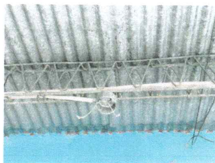
Foto 4: reparación de sistema eléctrico
