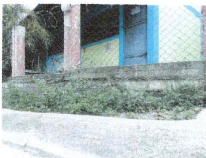
Foto 3: reparación de muro perimetral
