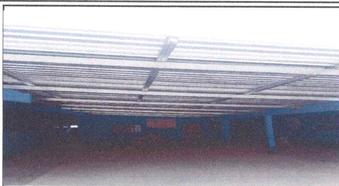
Foto 2: Finalizado colocacion de Costaneras del centro educativo
