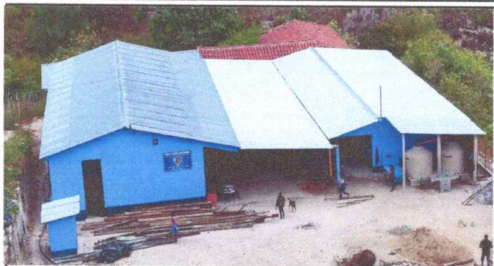
Foto1: finalizado el Techado de la Escuela Oficial Rural Mixta, Caserío Río Negro, aldea Exchimal.
