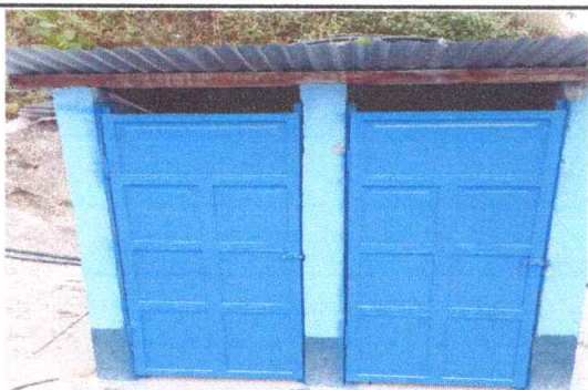
Foto 3: finalizado las Puertas de los servicios sanitarios
