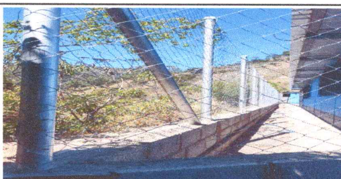
Foto 4: finalizado la Cituacion de la circulación de la Escuela .
