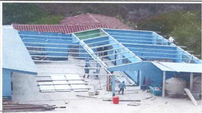
Foto1: En Proceso el Techado de la Escuela Oficial Rural Mixta, Caserío Río Negro, aldea Exchimal.
