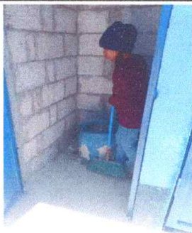
Foto 3: En proceso las Puertas de los servicios sanitarios
