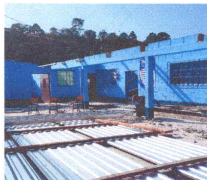
Foto 2: En proceso las Costaneras del centro educativo
