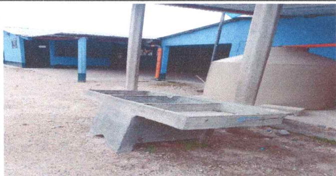
Foto 5: En proceso la pila de la Escuela de Río Negro.
