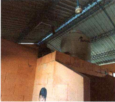
Fotografía 7: Cambio de tinaco, depósito de agua
