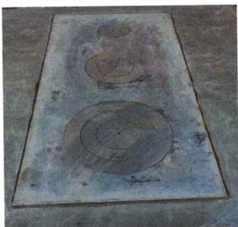
Foto 5: COCINA- Sustitución de plancha
