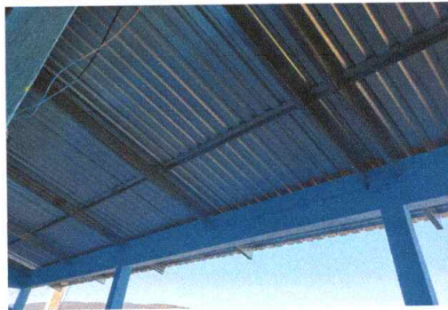
Foto 2: Sustitución de costanera de madera por tubos de metal
