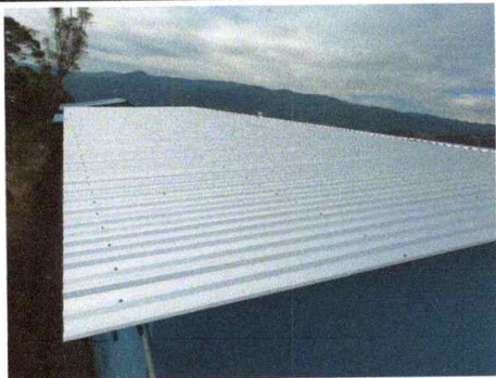
Foto 1: Tejado de la Escuela Oficial Rural Mixta Caserío Nueva Esperancita, aldea Exchimal.
