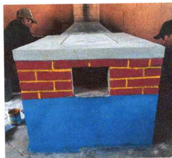
Foto 6: Sustitución de base para plancha de estufa rural
