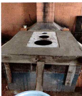
Foto 5: COCINA- Sustitución de plancha
