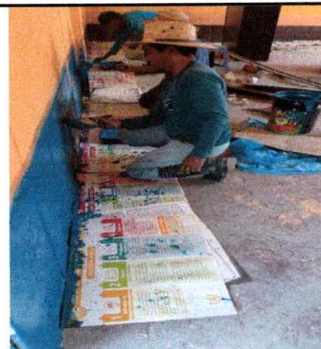
Foto 4: Zocalo interior y exterior del establecimiento
