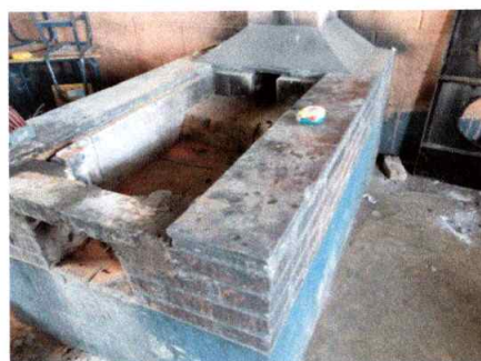
Foto 6: Sustitución de base para plancha de estufa rural
