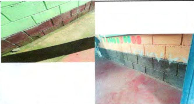
Foto 4: Zocalo interior y exterior del establecimiento
