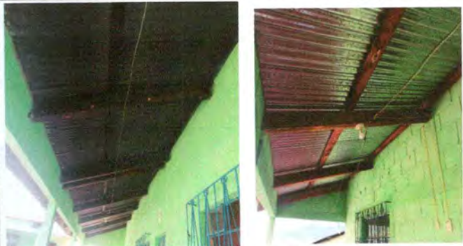
Foto 2: Sustitucion de costanera de madera por tubos de metal
