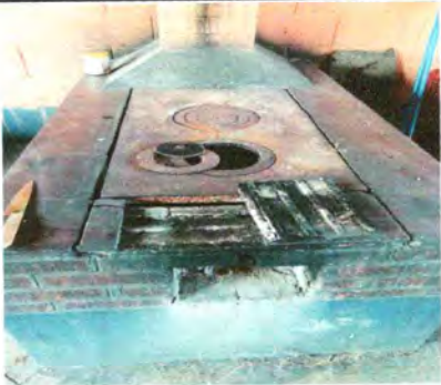
Foto 5: COCINA- Sustitucion de plancha
