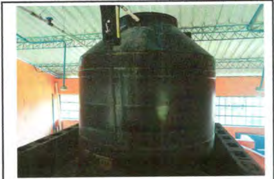
Fotografía 7: Cambio de tinaco, depósito de agua
