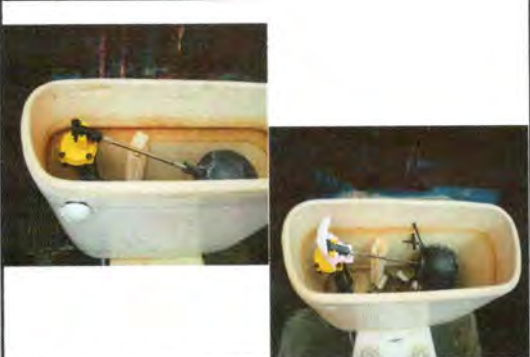
Fotografía 8. Sustitucion de inodoros de los baños de la escuela
