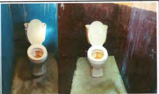
Fotografía 9. sustitución de torta de concreto en baños.
