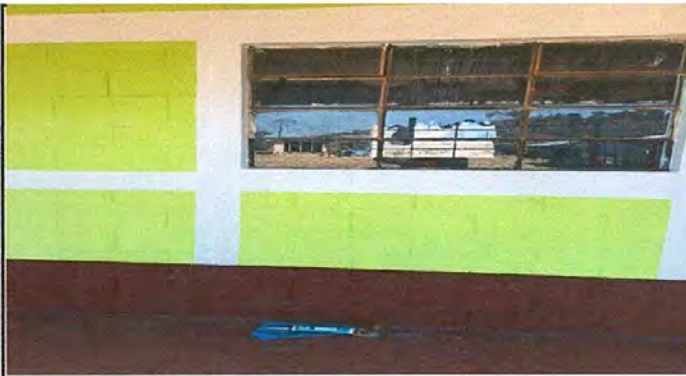
Foto 3: sustitución de vidrios
