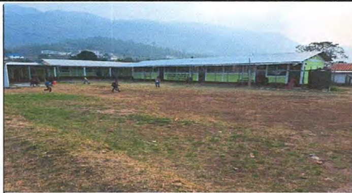
Foto 7: pintura en muros exteriores e interiores
