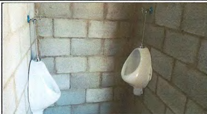
Foto 8: Sustitución de mingitorio
