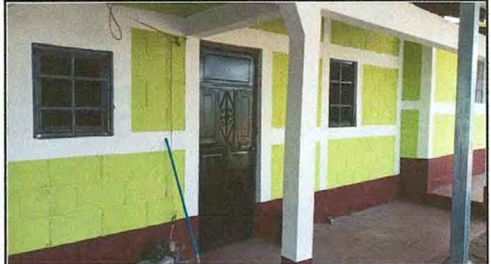
Foto 2: cambio de puertas, ventanas de metal
