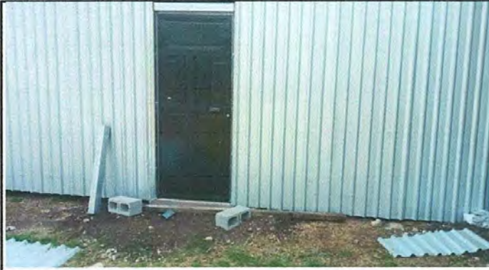
Foto 1: cambio de láminas
