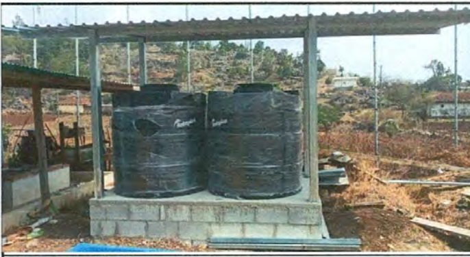
Foto 5: sustitución de deposito de agua.
