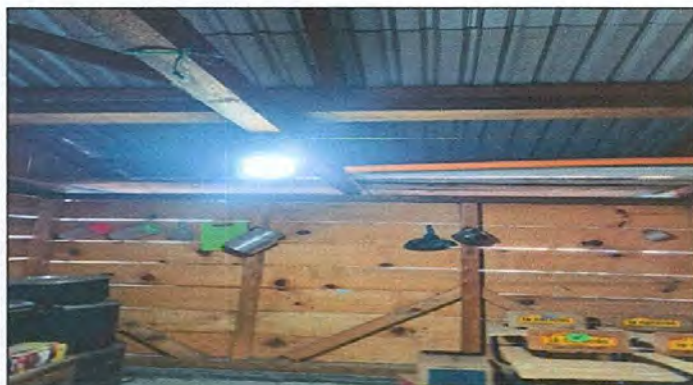
Foto 9: Reparación de sistema eléctrico
