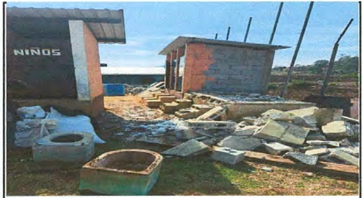
Foto 4: Mejoramiento de muro perimetral de block
