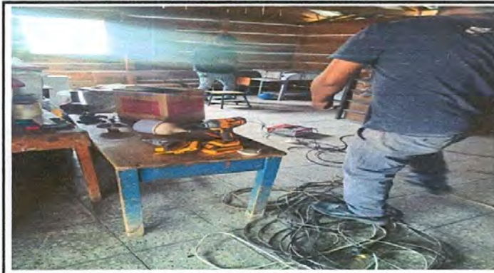
Foto 9: Reparación de sistema eléctrico
