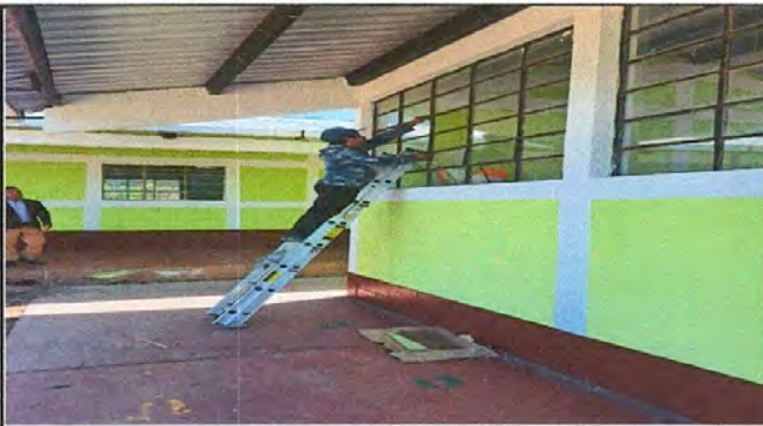
Foto 3: sustitución de vidrios
