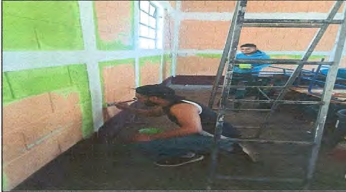
Foto 7: pintura en muros exteriores e interiores
