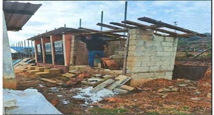
Foto 8: Sustitución de mingitorio
