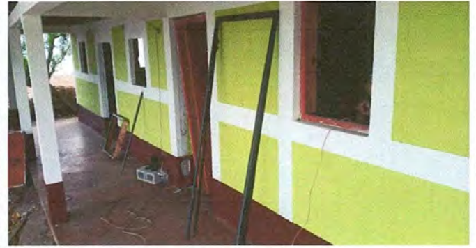
Foto 2: cambio de puertas, ventanas de metal
