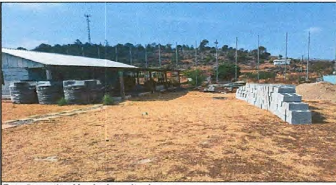
Foto 5: sustitución de deposito de agua.
