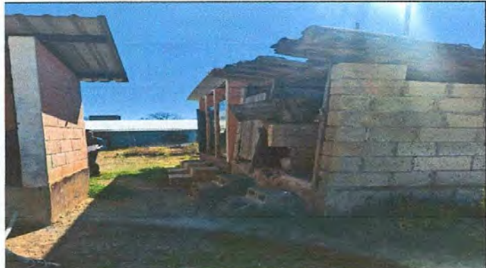
Foto 4: Mejoramiento de muro perimetral de block
