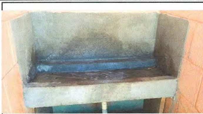
Foto 8 sustitución de mingitorio
