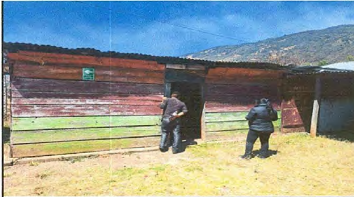
Foto 1: cambio de láminas
