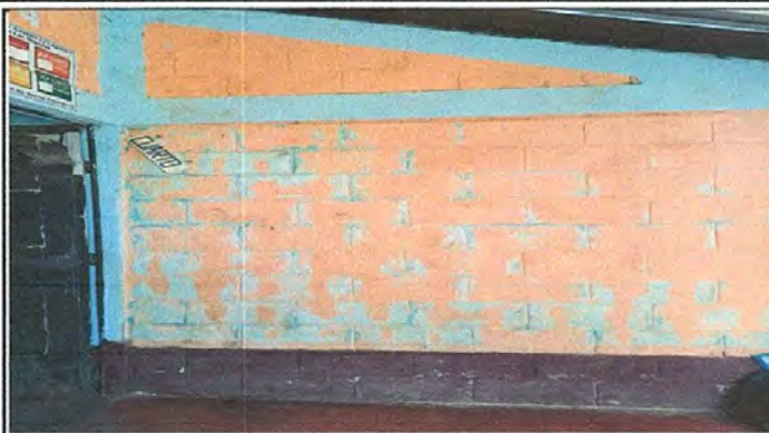
Foto 7: Pintura en muros exteriores e interiores
