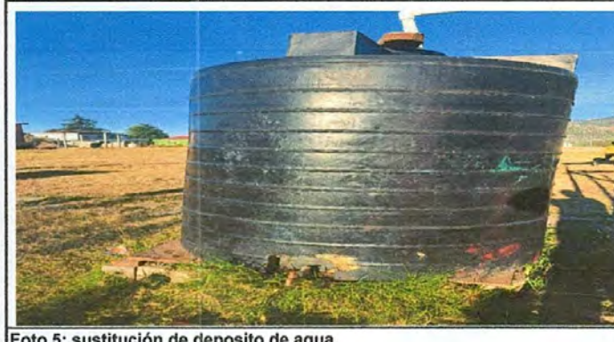
Foto 5: sustitución de deposito de agua.
