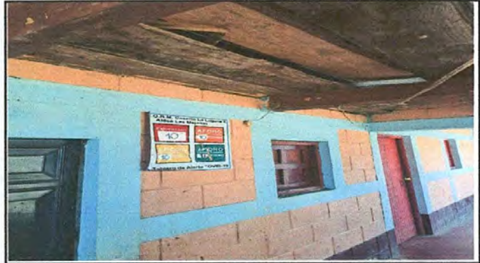
Foto 2: cambio de puertas, ventanas de metal
