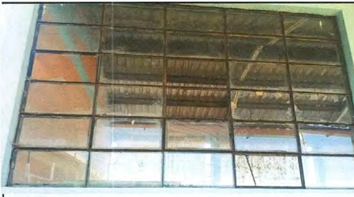
Foto 3: Sustitución de vidrios
