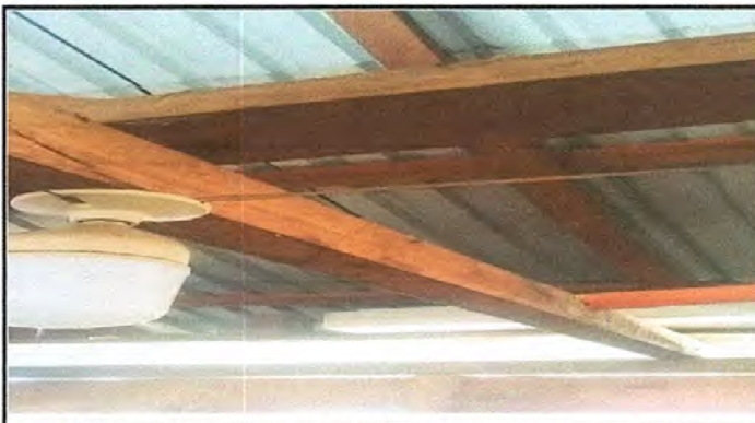
Foto 9: Reparación de sistema eléctrico
