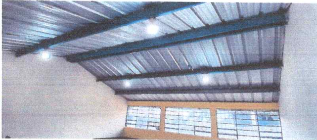
Foto7: Reparación de sistema electrico
