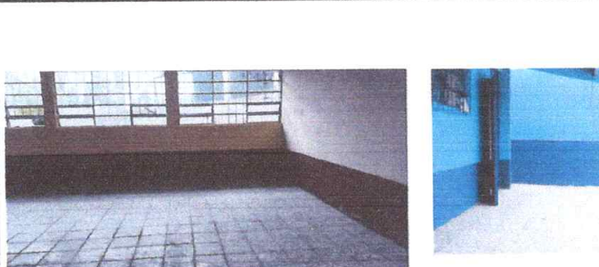
Foto 2: SUSTITUCION DE PISO DE CEMENTO LIQUIDO (A PISO DE GRANITO)
