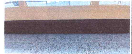
Foto 9: REPARACION DE REPELLO Y CERNIDO DE PAREDES
