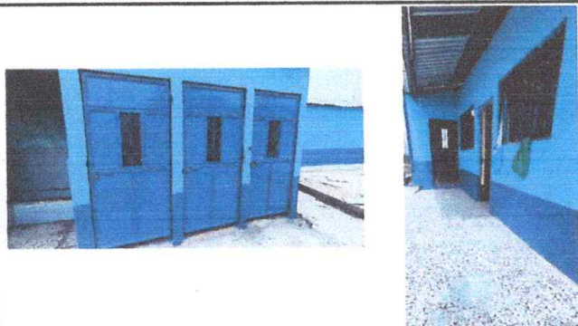
Foto1: Mantenimiento de puertas
