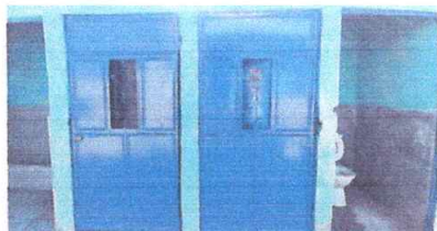
Foto 1: Mantenimiento de puertas
