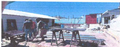
Foto 9: REPARACION DE REPELLO Y CERNIDO DE PAREDES
