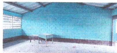
Foto 9: REPARACION DE REPELLO Y CERNIDO DE PAREDES
