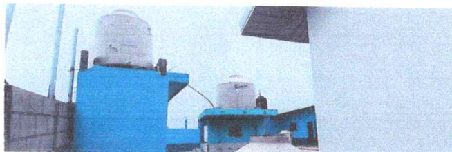
Foto 8: Reparacion y mantenimineto de cisternas/ depósitos de agua
