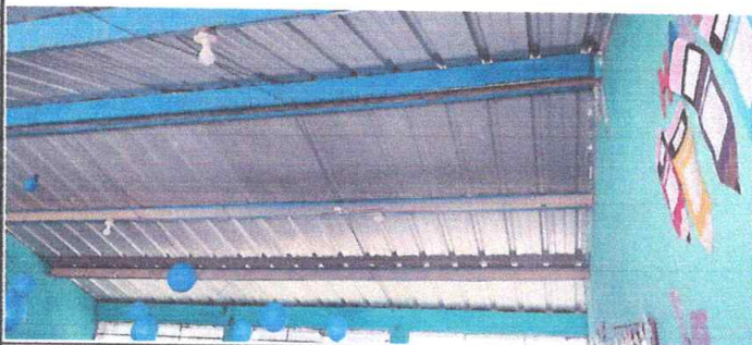
Foto7: Reparación de sistema eléctrico
