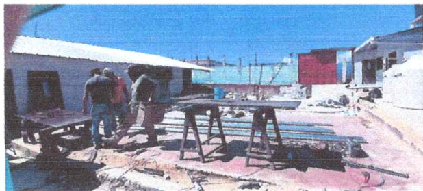
Foto 5: Mantenimiento de portones
