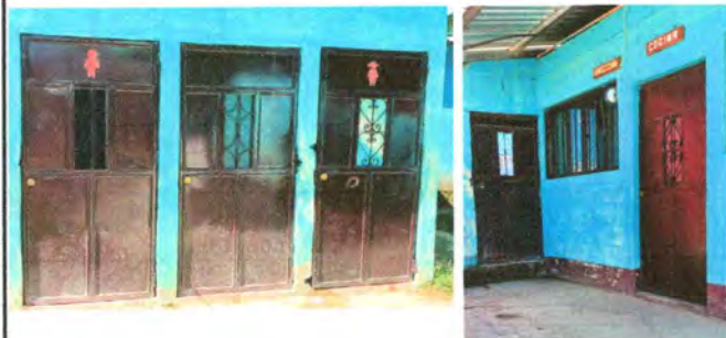
Foto1: Mantenimiento de puertas
