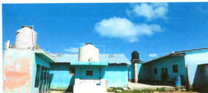
Foto 8: Reparacion y mantenimineto de cisternas/ depósitos de agua
