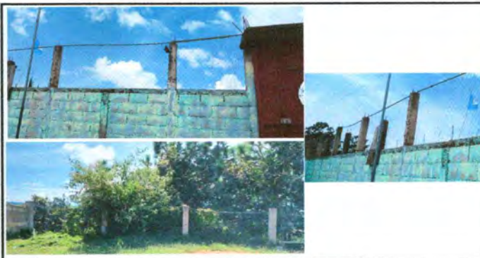
Foto 6: Sustitución de malla y tubos en muro perimetral
