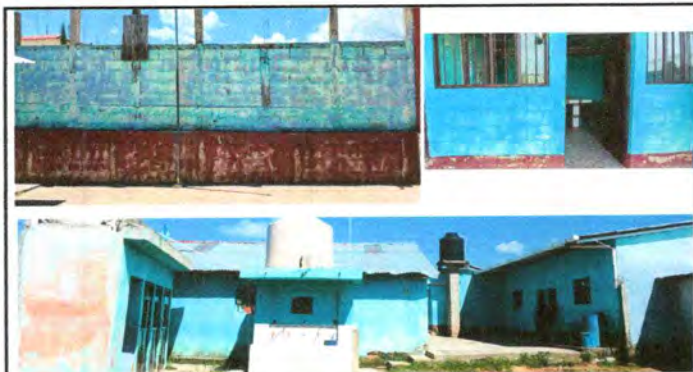
Foto 3: Pintura en exteriores
