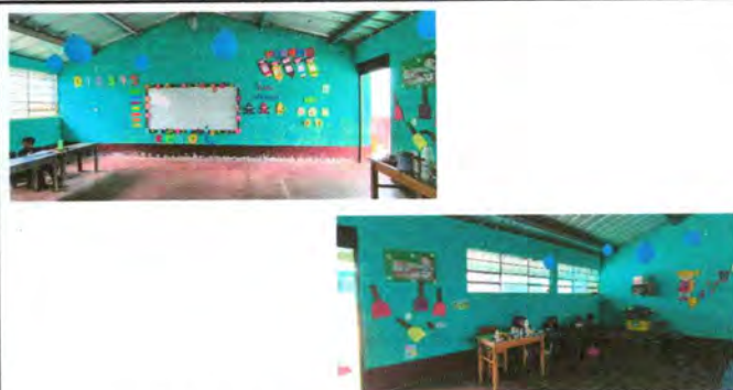
Foto 9: REPARACION DE REPELLO Y CERNIDO DE PAREDES
