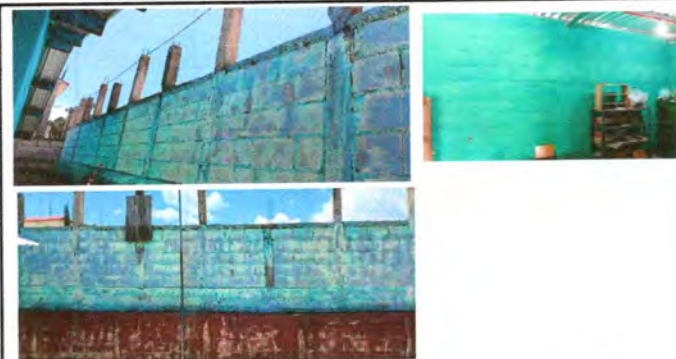
Foto 9: REPARACION DE REPELLO Y CERNIDO DE PAREDES
