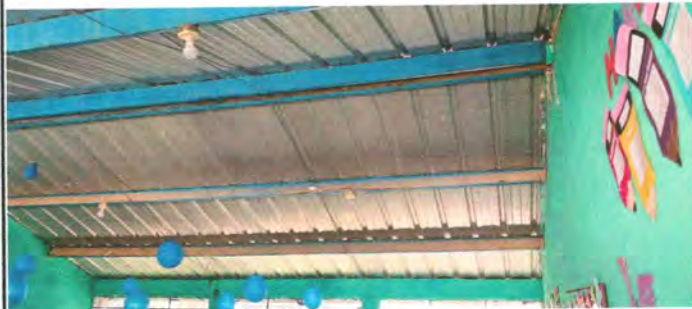
Foto7: Reparación de sistema eléctrico
