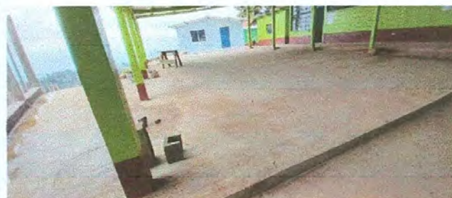
Foto 2: Finalización de Reparación de Piso de torta de concreto
