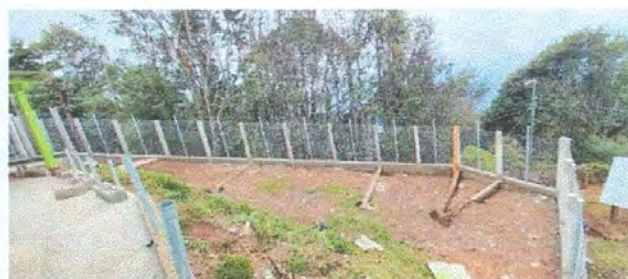
Foto 8: Finalización de Muro perimetral
