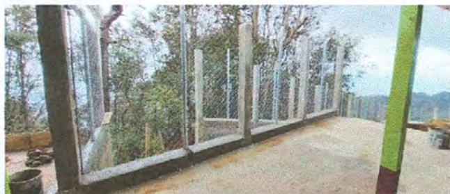
Foto 7: Finalización de Muro perimetral
