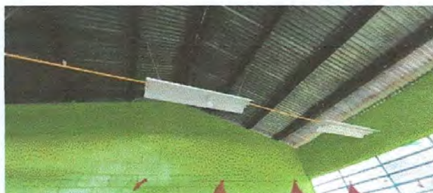
Foto 10: Finalización de Reparación de Sistema Eléctrico
