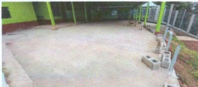
Foto 1: Finalización de Reparación de Piso de torta de concreto
