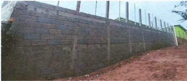
Foto 13: Finalización de Reparación de Muro de Contención
