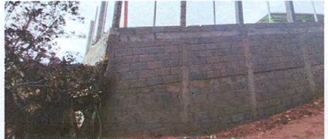
Foto 14: Finalización de Reparación de Muro de Contención
